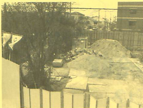
本体の基礎工事が進む市立園田保育所
